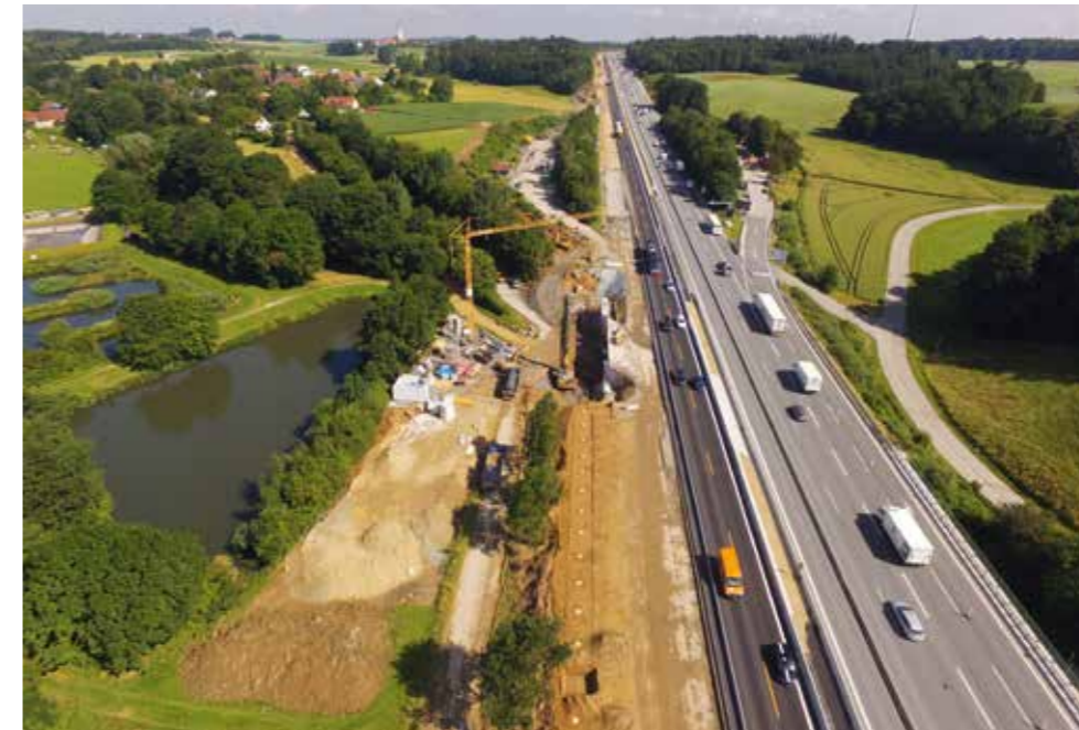
A 9, Temporäre Seitenstreifenfreigabe an der Richtungsfahrbahn München. Als Baufeld stand jeweils nur die halbe Fahrbahnbreite zur Verfügung, da während der gesamten Bauzeit sechs Fahrstreifen aufrecht erhalten wurden.
