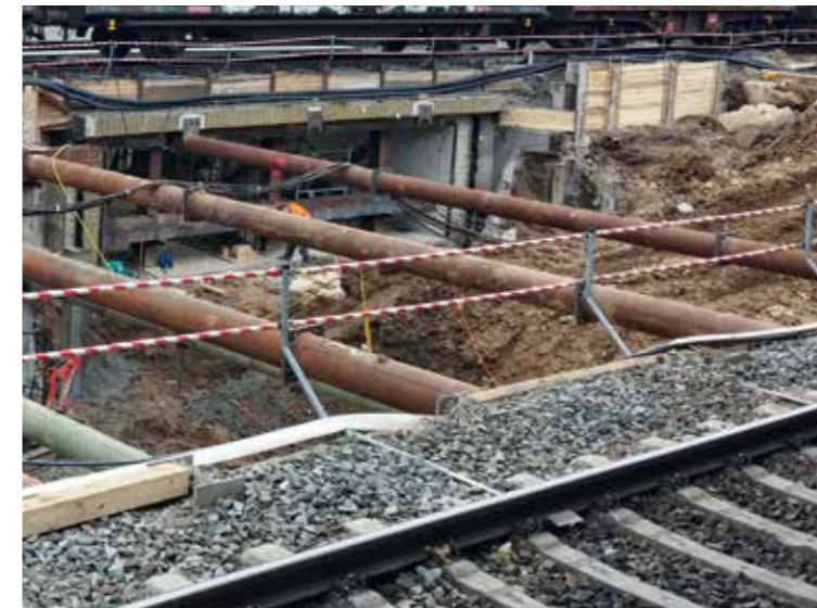
Bayerns größte Baustelle in Sachen Barrierefreiheit: der Würzburger Hauptbahnhof
