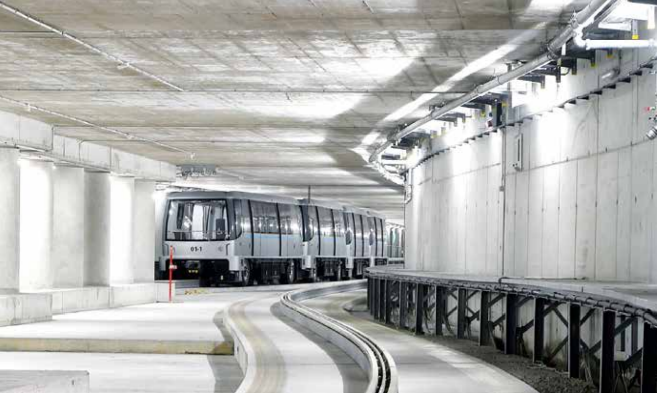
Die Züge des PTS verkehren fahrerlos zwischen dem Terminal 2 und dem Satelliten-Terminal.
