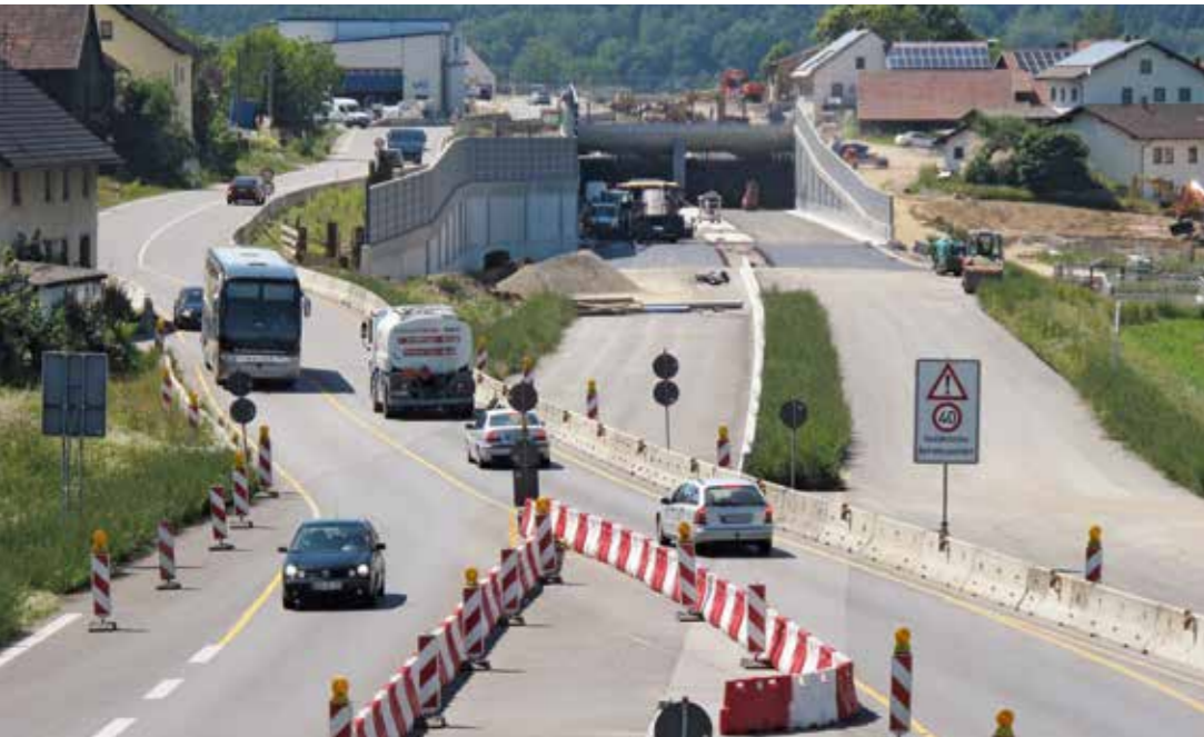
Mit dem zweibahnigen Ausbau der B 85 bei Wetterfeld (Landkreis Cham) verschwindet die Bundesstraße zukünftig in einem 180 m langen Tunnel. Trotz komplizierter Verkehrsführung im Baustellenbereich konnten sowohl die Bauzeit als auch der Kostenrahmen von 42 Millionen Euro eingehalten werden.
