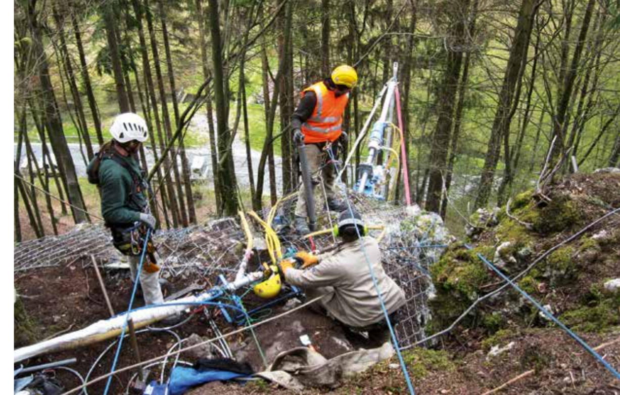
St 2191, Fellsicherungsmaßnahmen im Kleinziegenfelder Tal
