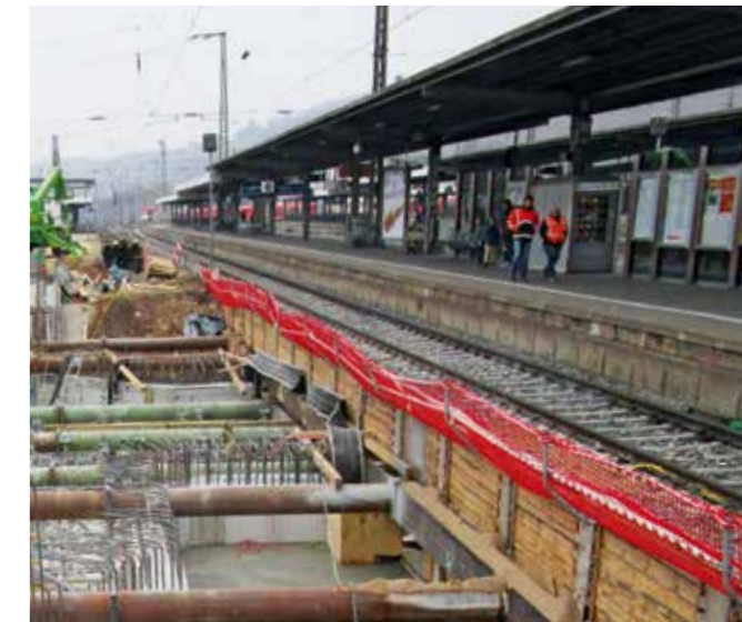
Blick auf die beengte Baustelle zwischen den Gleisen
