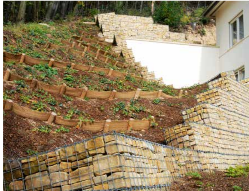
Gabionen als Böschungssicherung
