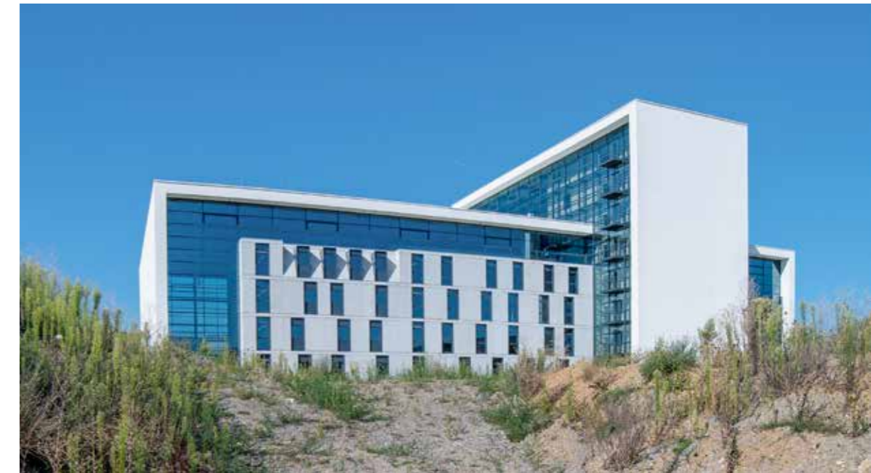
Stützenfreie Übungshalle der Staatlichen Feuerwehrschiele Würzburg
